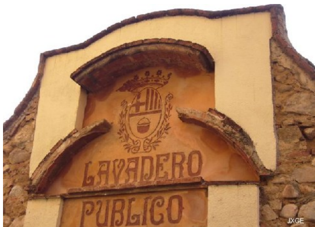
Façana del safareig de Caldes de Montbui
