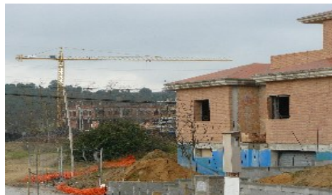
Procés ràpid de construccions prop de la Cruïlla
