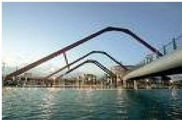
Instal·lacions del Fòrum al parc Fundidora
