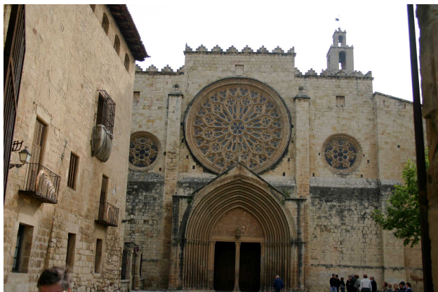
Detall de l'entrada principal de l'església
